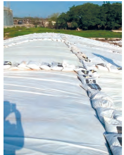
Foto 8. As cores claras reflicten os raios de sol e así mantense unha menor temperatura dentro do silo
