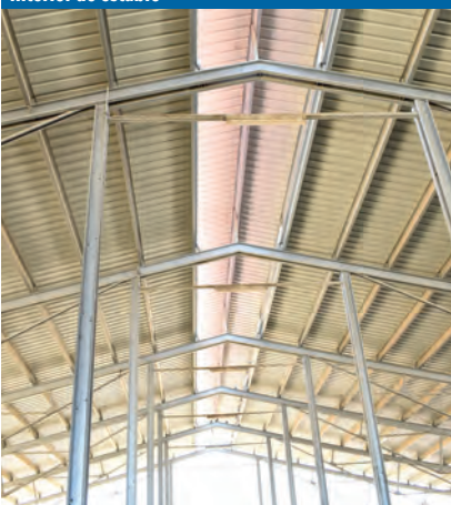
A apertura cenital do teito favorece a ventilación no interior do establo
