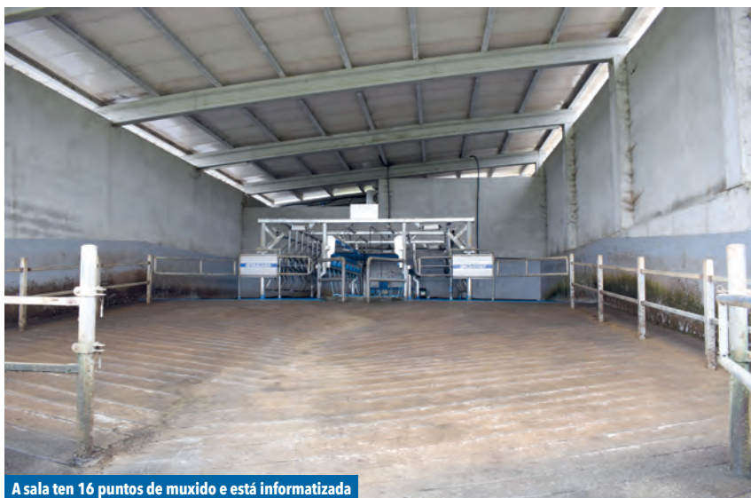
A sala ten 16 puntos de muxido e está informatizada
