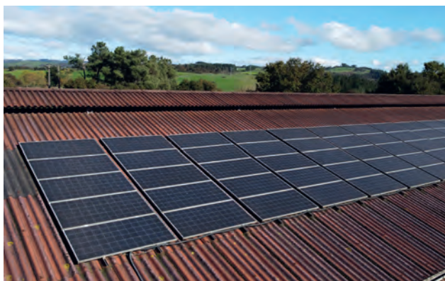
A serie de placas fotovoltaicas con 15 quilovatios de capacidade cóbrelles o gasto do muxido do mediodía
