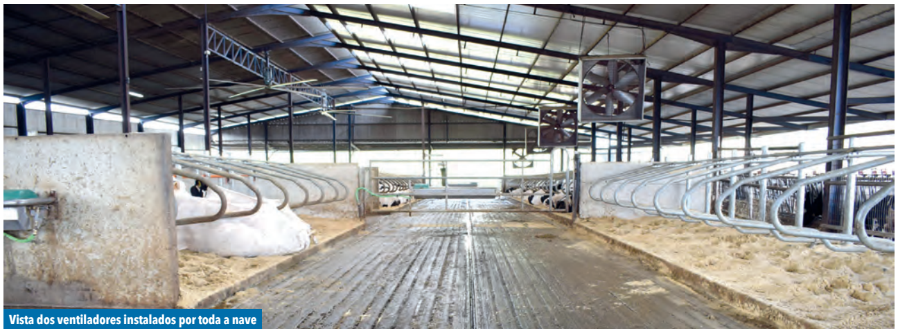
Vista dos ventiladores instalados por toda a nave
