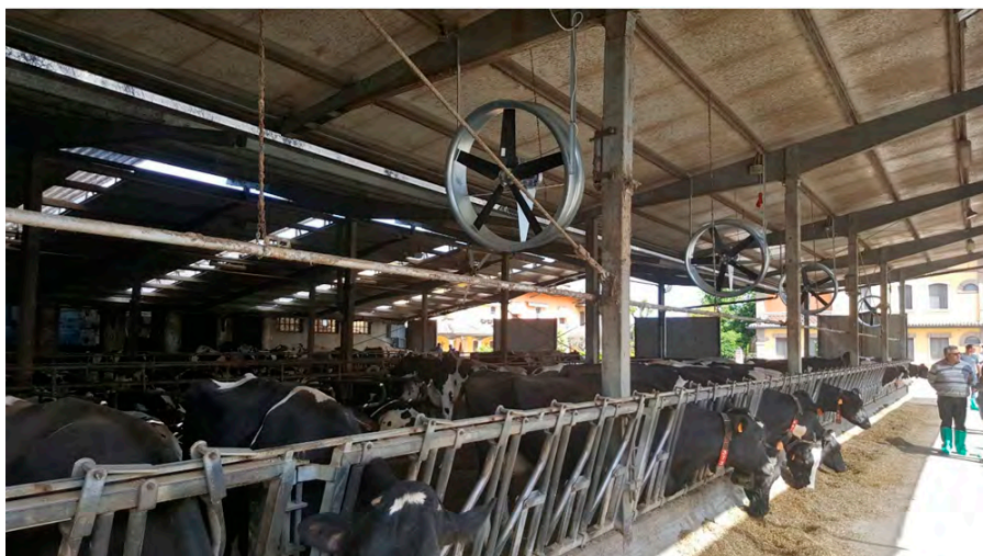
Imaxe 3. Área da liña de alimentación en 2017, despois da instalación do arrefriado intenso
